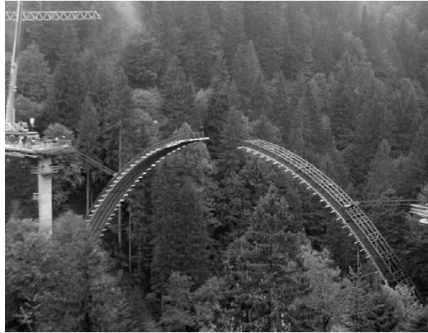
Fig. 15. Puentes sobre el Lesach, abatimiento de la estructura metálica (Peter Schallaschek).
