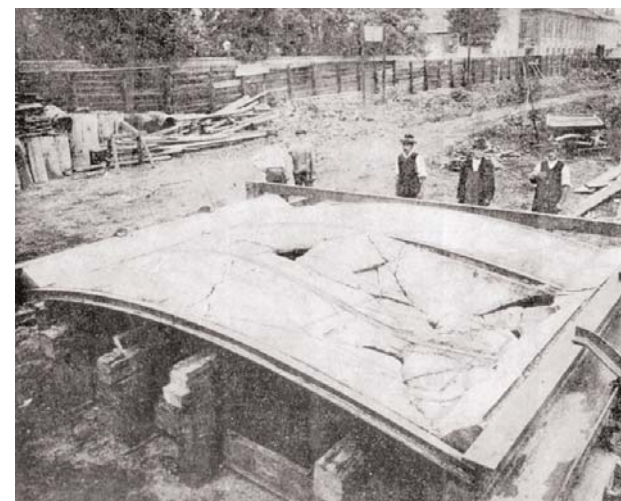
Fig. 3. Bóveda del sistema Melan después de la rotura. (ÖIAV 1895, fig. 12).
